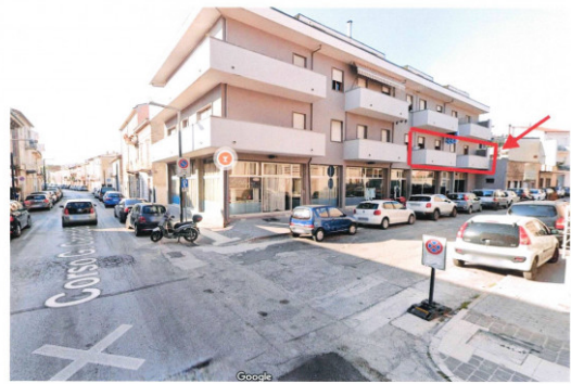
Primo piano lato ovest facente parte di un edificio di tre piani
